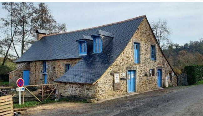
Toiture du moulin rénovée
